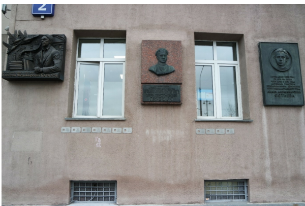
Abb. 4 Haus an der Uferstraße, 27. Oktober 2021 | Image 4: House on Bank Street (Naberezhnaya) 27 October 2021
